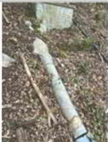
Photo n° PhA001 Localisation : Parties extérieures Ouvrage : 6 - Conduits et accessoires intérieurs - Conduits de fluides (air, eau, vapeur, fumée, échappement, autres fluides) Partie d'ouvrage : Calorifuge (tresses, coquilles, matelas...) Description : Conduit en fibro-ciment
