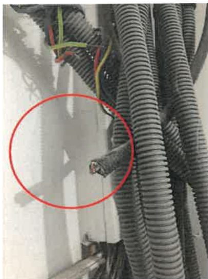
B.7.3 d) : L'installation électrique comporte au moins une connexion avec une partie active nue sous tension accessible. Observation : Câbles à nu
