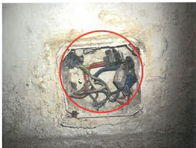
B.7.3 d) : L'installation électrique comporte au moins une connexion avec une partie active nue sous tension accessible. Observation : Dominos
