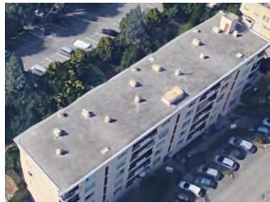
L'isolation thermique de la toiture fait l'objet d'une proposition dans le présent document (gain énergétique, évaluation de l'investissement et du temps de retour). Cette action de travaux est intéressante du fait de la forme allongée des bâtiments, et donc la surface importante de toiture disponible témoignant d'un gisement d'économie d'énergie non négligeable (16% eds déperditions).
