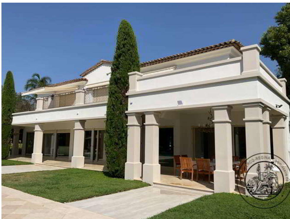
Vue d'ensemble de la Terrasse couverte
