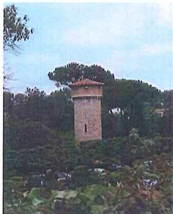
5- Château d'eau du Golf AM 56-58
